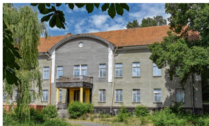
An der Vorderseite wurde der gesamte Stuck entfernt. FOTO: P. PLEUL
